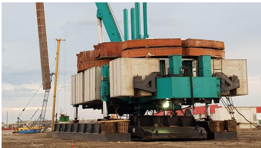
Рис. 4. – Вдавливание призматических свай сечением 35x35 см на площадке строительства ЛЦ «Адыгея-2»
