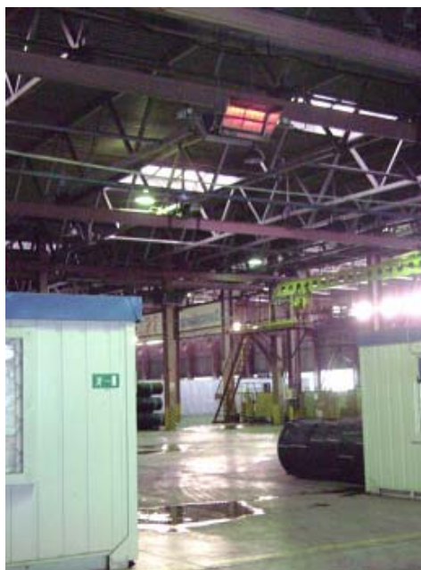
Рис. 1. Разрушение ограждающих конструкций вблизи ГИИ.
