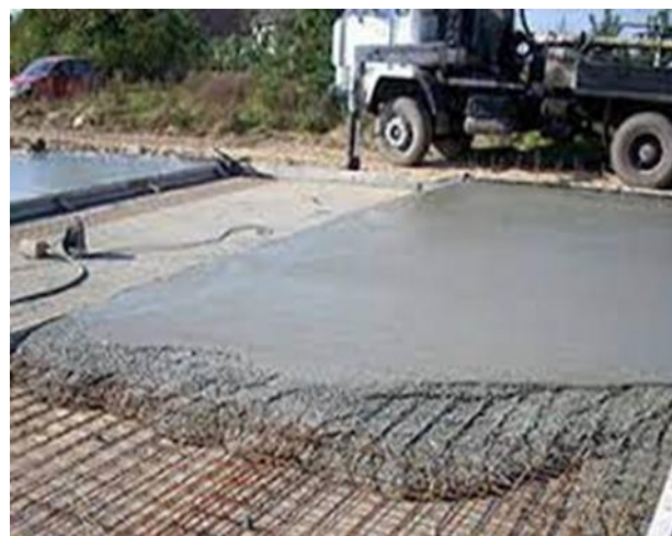
Рис. 2. – Применение базальтовой фибры при устройстве фундамента [4]
