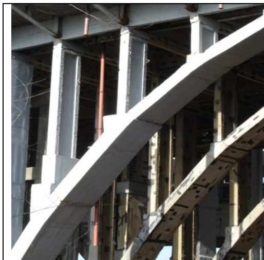
Рис. 1. Усиление крайних арок моста в Волгограде
