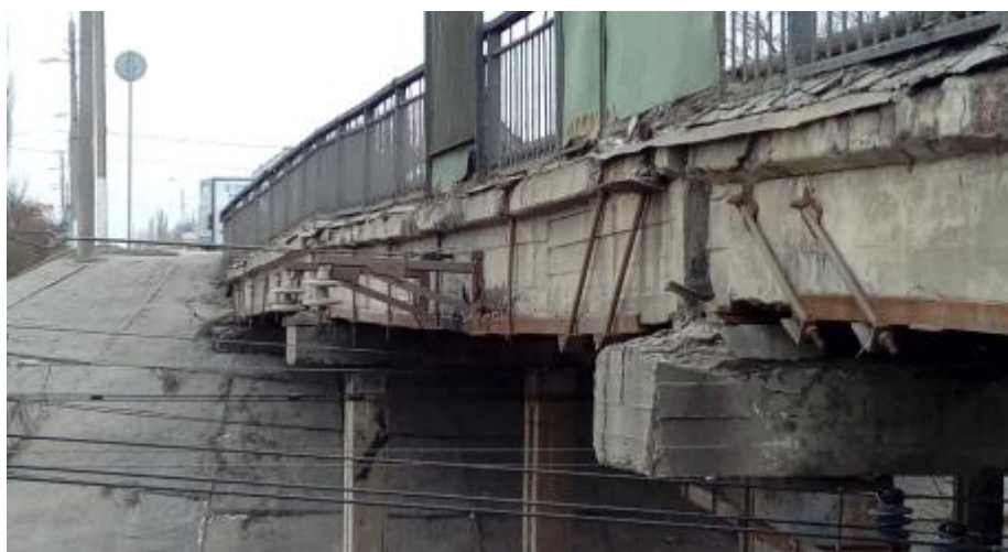
Рис. 3. Усиление балок путепровода в Волгограде.
