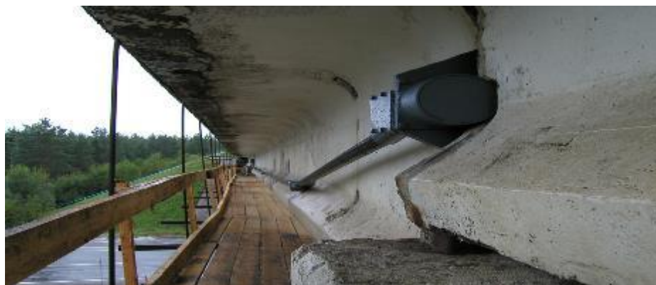
Рис. 4. Усиление напрягаемым пучком [7].
