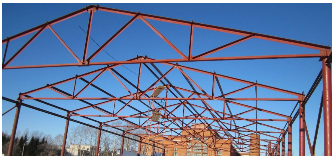
Рис. 1. - Фермы из одинарных прокатных уголков в составе покрытия цеха, строящегося в одном из районов г. Хабаровска
