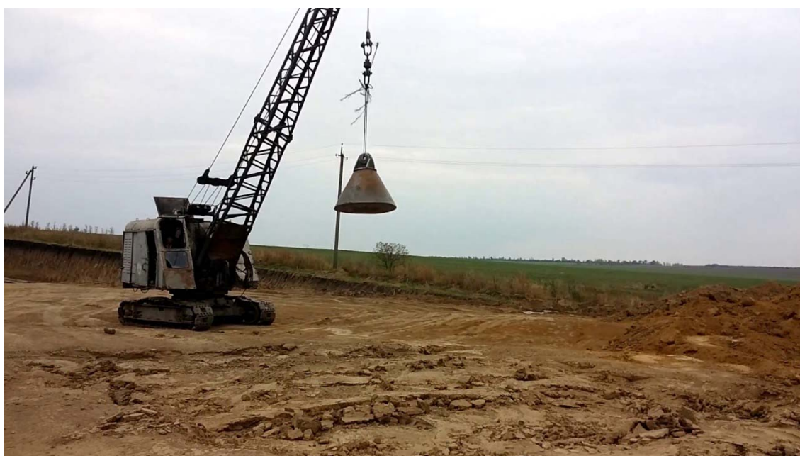
Рисунок 1. Кран-экскаватор с трамбовкой на строительстве нефтеперегонного завода
