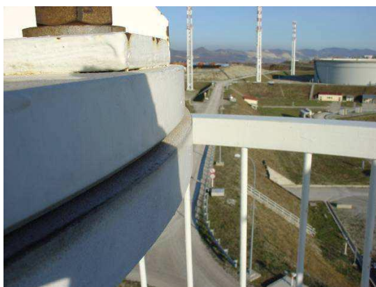
Рис. 3. – Смещение верхнего фланца относительно нижнего
