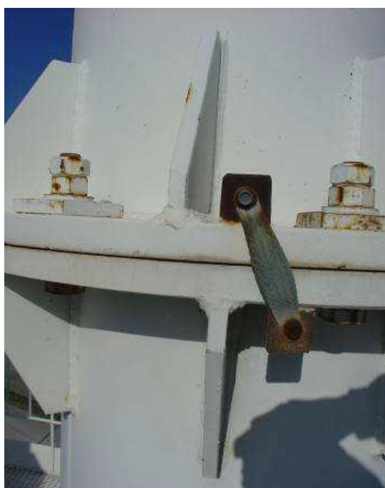
Рис. 4. – Смещение верхнего ребра относительно нижнего
