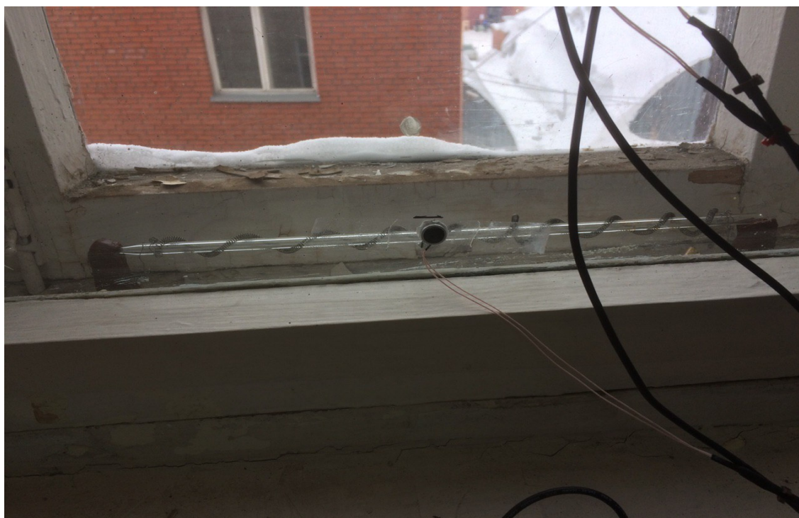
Рис.16. Иллюстрация греющего элемента.
