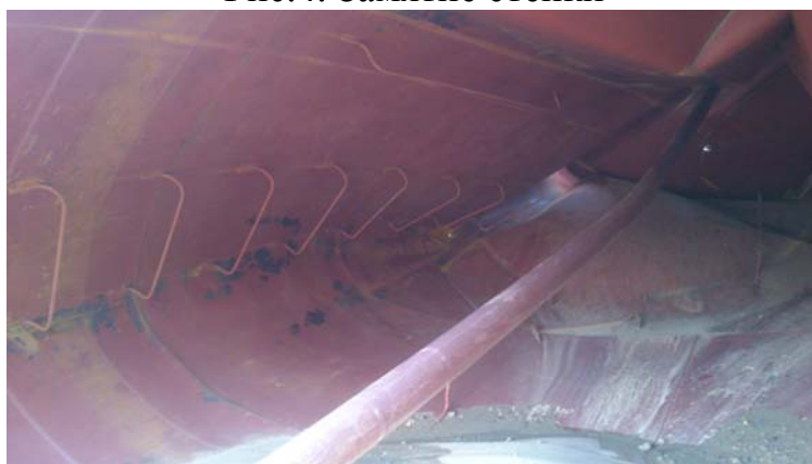
Рис.5. Отсутствуют диафрагмы жесткости
